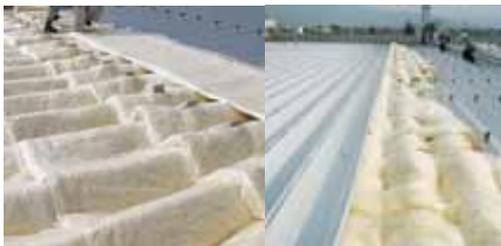
二重折板屋根の間にグラスウールを敷き込んだ、高断熱・高气密性の屋根システム
