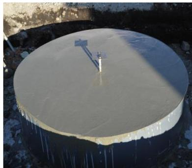
工場で製作された薄板鋼板製型枠に鉄筋、アンカーボルトを現場でセットするだけで、専門工を必要とせず、省施工化を実現する基礎システム
